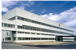
名古屋第3地方合同庁舎改修工事【名古屋市中区】
